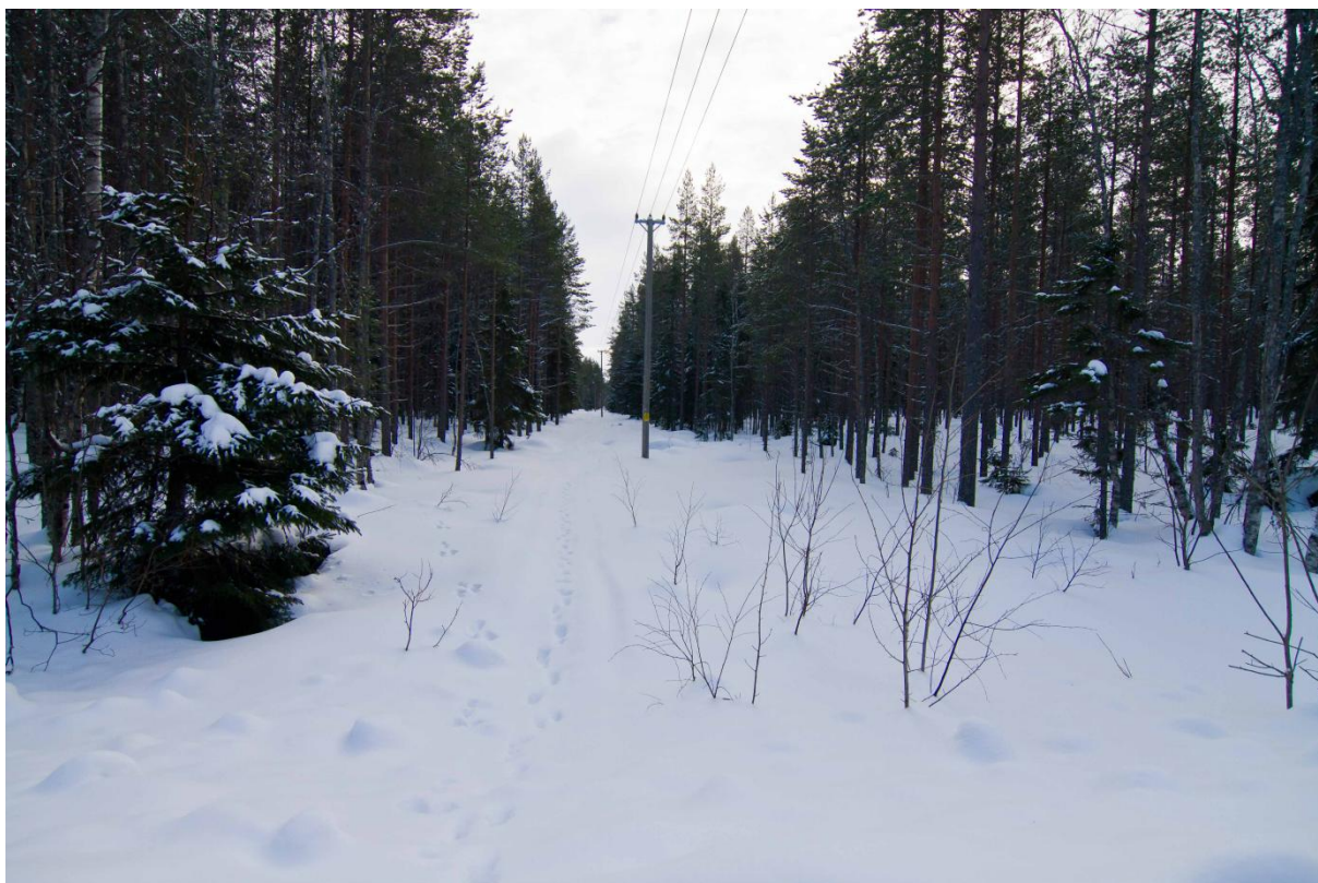
Bild 2: Kraftledningsgatan söder om vägen. Bilden är tagen från vägen.
